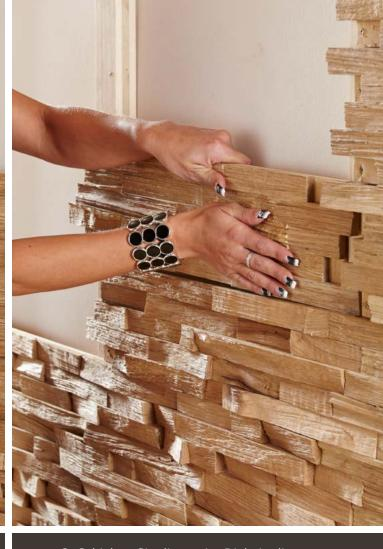
1. Beginnen Sie unter der ersten Reihe. Schneiden Sie die erste Diele links gerade ab. Der abgeschnittene Teil der Diele soll mindestens 15 cm lang sein. Die unterste Reihe ist mittels Wasserwaage in eine waagrechte Position zu montieren. Bitte beachten Sie, dass der Ausgangspunkt für die Montage der nächsten Reihe wichtig ist.
